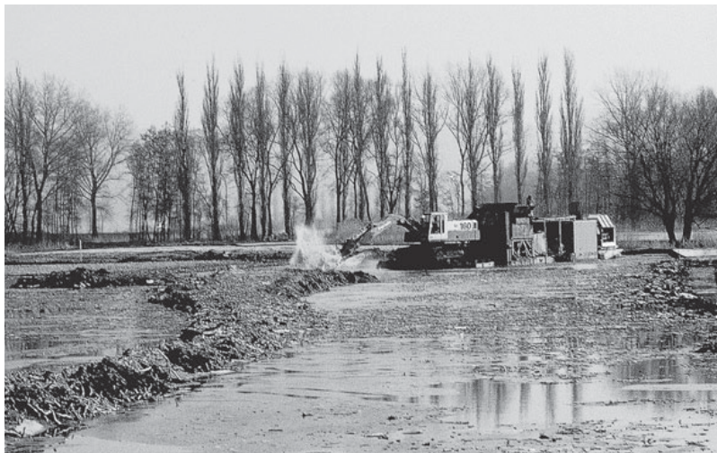
Abb. 3. Schwimmbagger im Fanel, bei der Schaffung des Graben-Teichsystems. Aufnahme C. Marti, 11. März 1987. – The Fanel reserve in March 1987.
